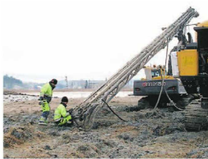
Arbetslaget jobbar på i kylan med att blanda kalk och cement i pelare som hjälper till att stabilisera marken.
